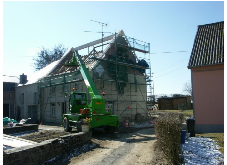
Während dem Umbau
