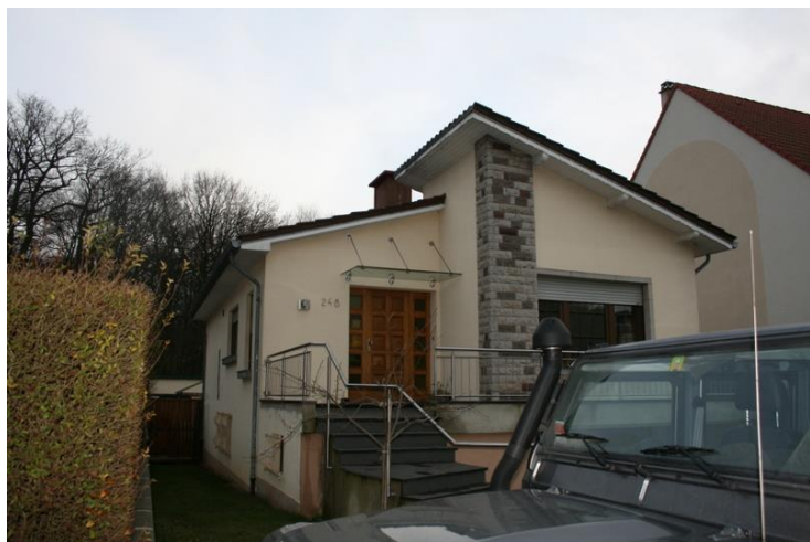
Avant la transformation - vor dem Umbau
