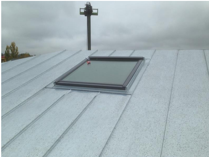
Velux dans toiture en zinc
