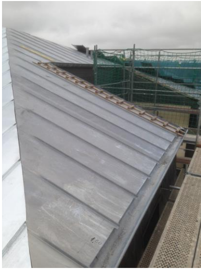
Chantier en zinc
